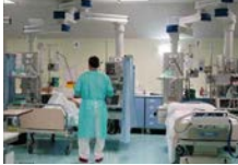
Post-chauffage dans les centrales de traitement de l'air, contrôle de l'humidité dans les hôpitaux et les laboratoires
