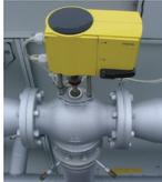
Apparecchiatura per il trattamento dell'acqua      Valvola a 3 vie
