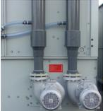
Dispositif thermoplongeur      Pompe de réserve
